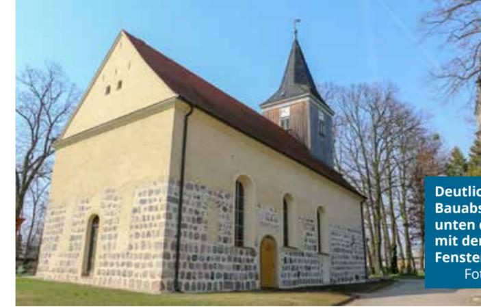
Deutlich sind die beiden Bauabschnitte zu sehen, unten die Feldsteine mit den zugemauerten Fenstern.
