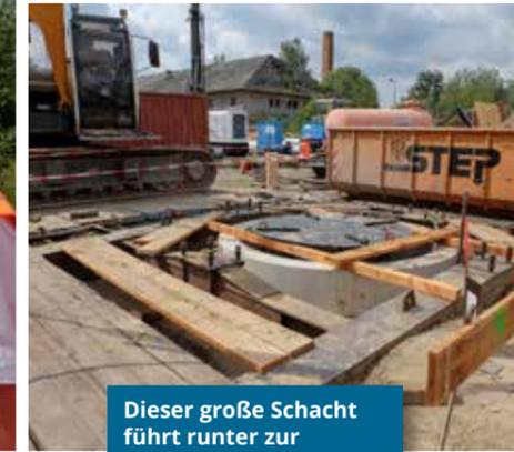
Dieser große Schacht führt runter zur Drainage. Fotos: sk
