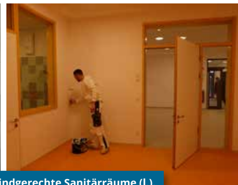
Kindgerechte Sanitärräume (l.). Letzte Malerarbeiten (o.).
