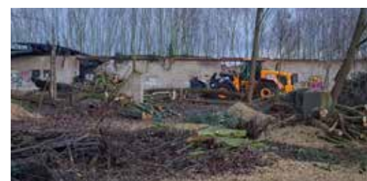
Der alten Schafstall wurde Anfang Februar abgerissen. Zahlreiche B ume mussten fallen. Foto: privat
