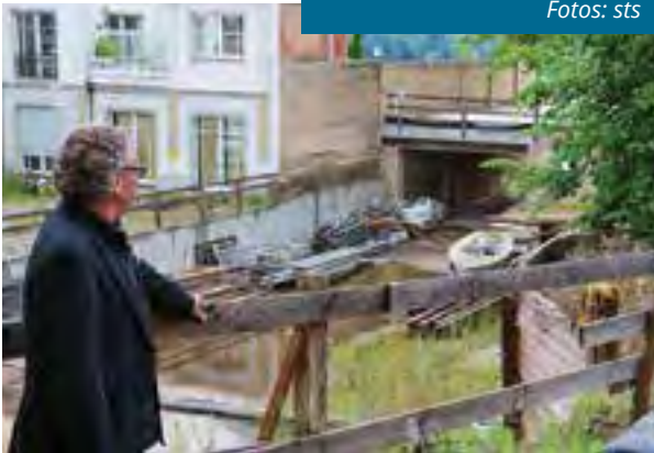
Zwick möchte die Baugrube bald schließen und die Café-Terrassen eröffnen Fotos: sts
