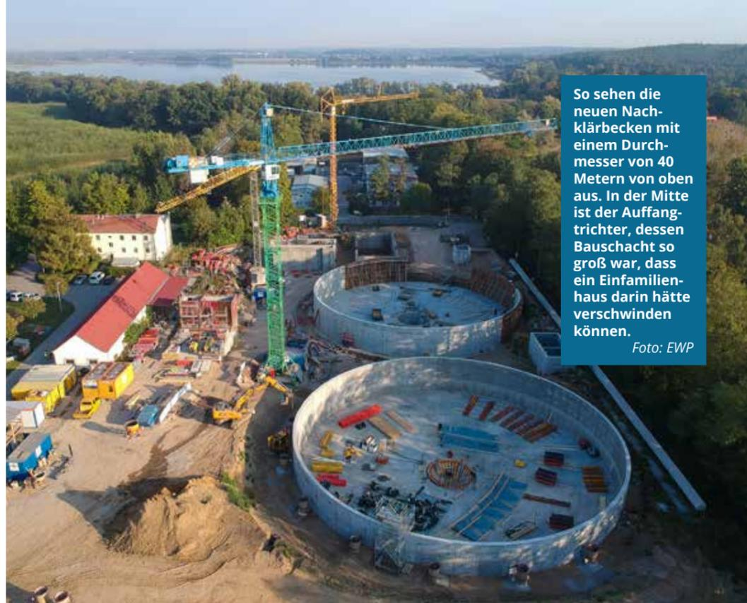
So sehen die neuen Nachklärbecken mit einem Durchmesser von 40 Metern von oben aus. In der Mitte ist der Auffangtrichter, dessen Bauschacht so groß war, dass ein Einfamilienhaus darin hätte verschwinden können.
